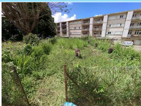
Matériaux : Z11 - Toiture terrasse - Souche de cheminée - enduit + peinture Prélèvement : P025 Description : enduit + peinture Localisation : SOUTE A MUNITION - TOIT - Souche de cheminée Résultat : Absence d'amiante
